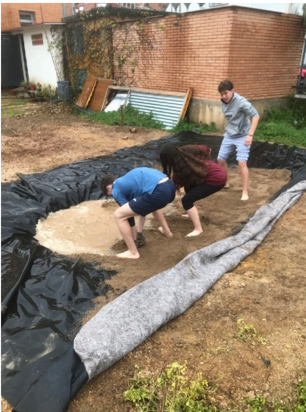
Instalación de la membrana aislante en la charca
