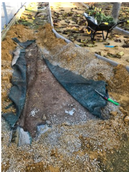
Trabajos para extraer la malla antihierbas/humedad
